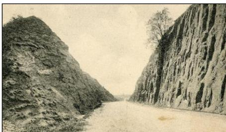
les matériaux extraits de ces rochers servaient pour réaliser le chemin sur une hauteur suffisante, en dehors des inondations régulières du ruisseau de l'Eau d'Heure. Seules les nouvelles technologies en génie civil développées à l'époque avaient permis la réalisation de ce tronçon.
